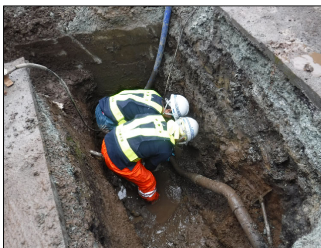
【漏水管修繕状況】
