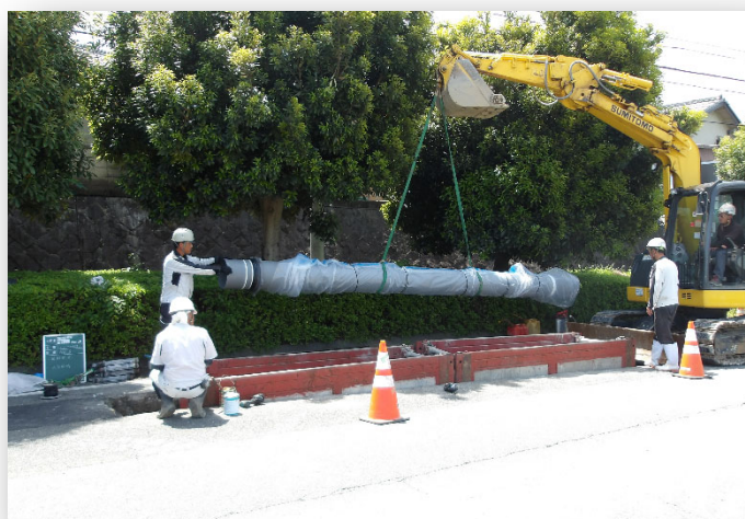
【配水本管布設替工事】
