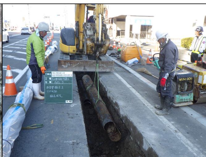
【老朽管撤去状況】
