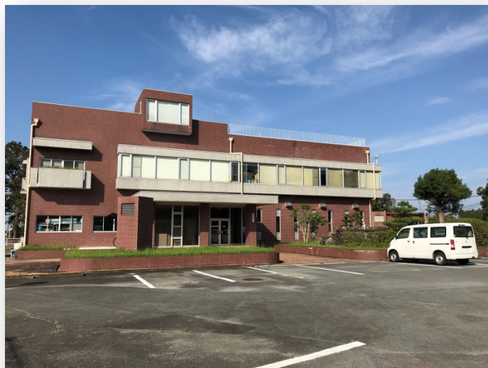
【中須水源地水道管理センター】
